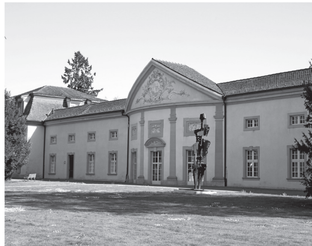
Pfaffnau, Kloster St. Urban, Orangerie, Ansicht von Nordwesten.
