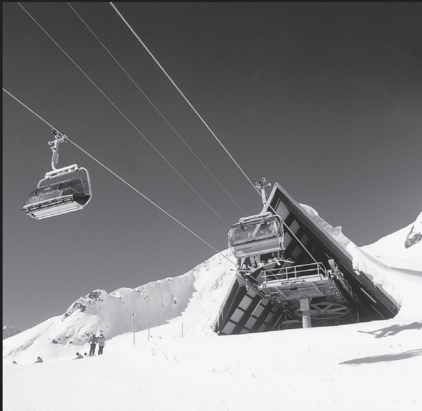
Bearth & Deplazes: Carmenna-Sesselbahn, Bergstation.
