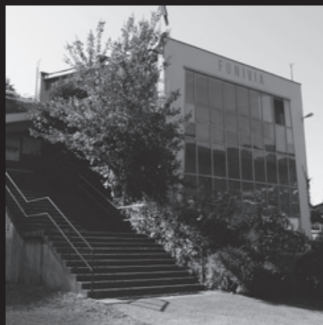
Talstation der Pendelbahn von Brusino-Arsizio.
