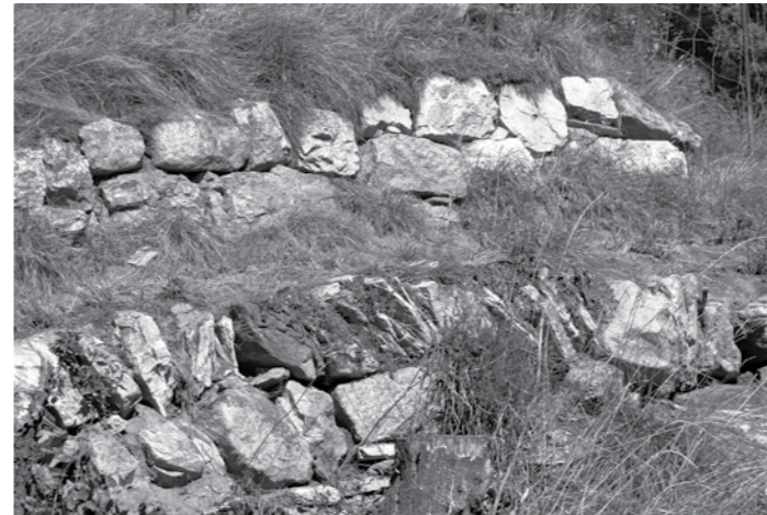
Trockenmauer auf dem Kulturweg – einem alten Saumweg – zwischen Ausserberg und Raron VS.
