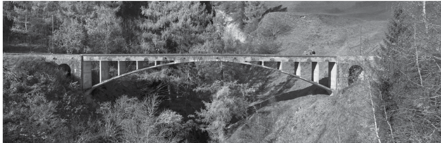
Die 1925 erbaute Maillartbrücke über das Valtschielbachtobel bei Donat GR: Auffallender Kontrast zwischen filigranem Beton-Stabbogen und wuchtigerem Natursteinwiderlager.
